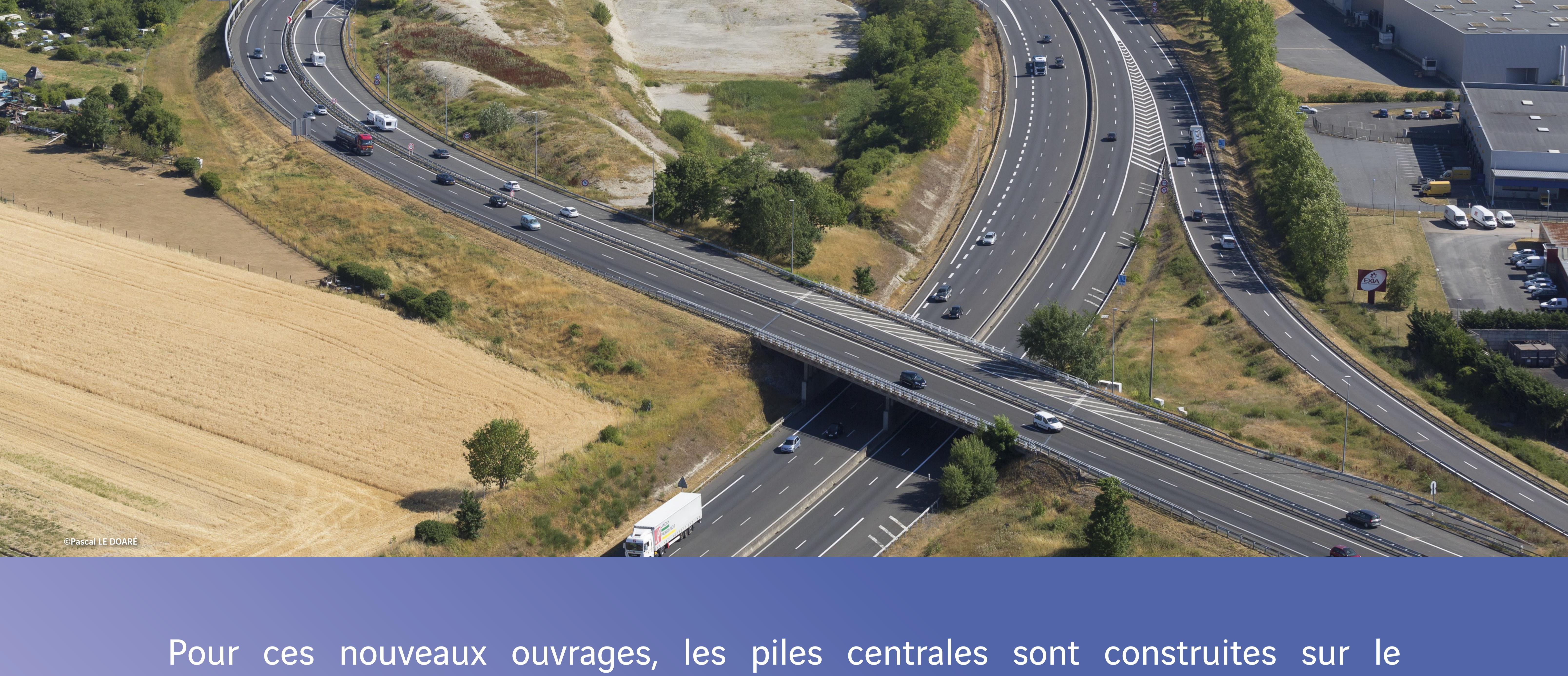
Pour ces nouveaux ouvrages, les piles centrales sont construites sur le terre-plein central, sous circulation. Le reste de l'ouvrage (piles latérales, culées...) sera réalisé sur le bord de l'autoroute. La pose des poutres se fera de nuit, avec basculement de circulation sur le sens opposé, et le tablier sera coulé, constituant ainsi le nouveau pont. La circulation sur l'autoroute A10 sera interrompue quelques heures, de nuit, afin de déconstruire les anciens ouvrages en toute sécurité.
