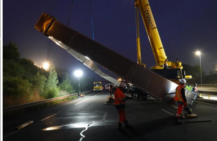
Dans la continuité des travaux de signalisation provisoire réalisés début mars, les opérations de préparation de la reconfiguration de la bifurcation A10/A71 se poursuivent. Ainsi le marquage jaune, la pose de murs béton sur les voies de l'autoroute et la dépose de portiques de signalisation sont entrepris. Ces travaux se déroulent de nuit, sous fermetures de sections, afin de sécuriser l'intervention des équipes.
