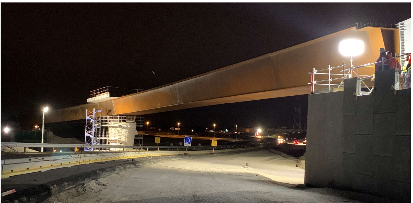
L'ensemble de la charpente de l'ouvrage « saut de mouton » surplombe désormais les 6 voies de l'A10 et les 2 voies de la bretelle Vierzon-Paris (A71)
